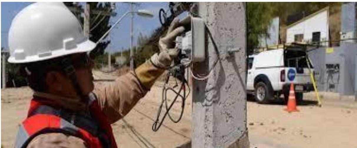
El empalme es el punto de conexión existente entre el poste de alumbrado público y la caja, en donde se instala el medidor de energía y el automático solicitado a la empresa eléctrica.
