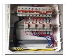
Los interruptores automáticos individuales controlan por separado la llegada de electricidad a los diferentes circuitos de la casa: alumbrado, calefacción, enchufes, etc.
